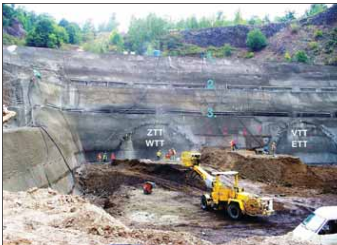
Obr. 5 Pohled na zajištění stěny raženého jižního portálu (září 2008) Fig. 5 View of the temporary mined portal wall stabilisation (September 2008)
