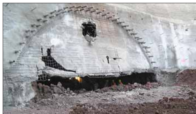
Obr. 14 Prorážka VTT do severní portálové stěny na konci května 2009
