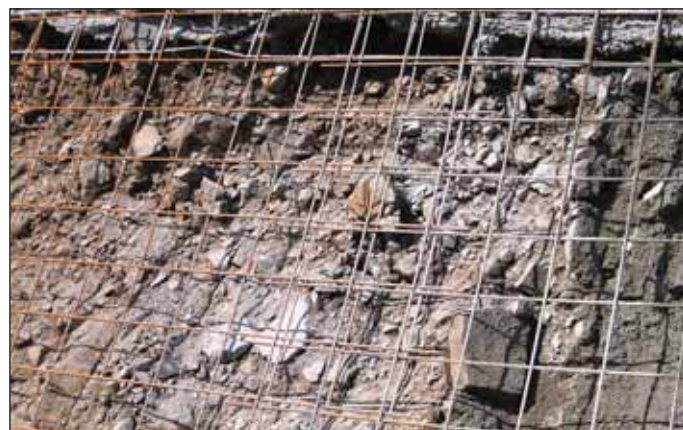
Obr. 3 Zvětralé čediče a tufy zastíženy při hloubení jámy pro jižní portál Fig. 3 Character of the weathered basalt and tuff encountered when excavating the portal cut
